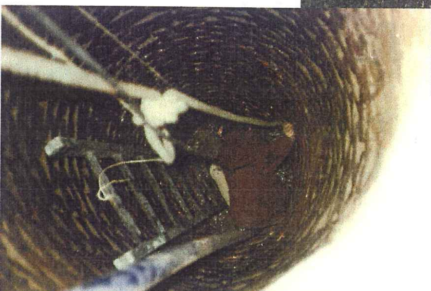
Droogpompen van een 16e eeuwse waterput. Oude Kijk in't Jatstraat 6 Winter 1983.
