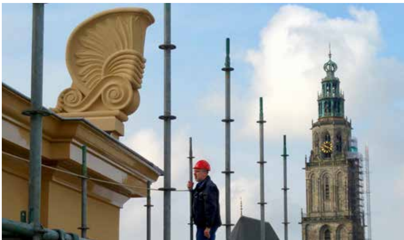
Toezicht en handhaving, monumenteninspecteur aan het werk bij de restauratie van de Stadsschouwburg.
