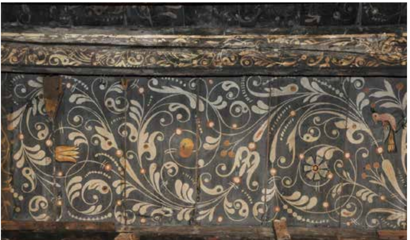
Bouwhistorisch onderzoek, Herestraat 42, detail van de bij toeval aangetroffen plafondbeschildering uit 1637. Voorafgaand aan de sloop is het plafond zorgvuldig gedemonteerd en het zal herplaatst worden in het op te richten historisch museum.
