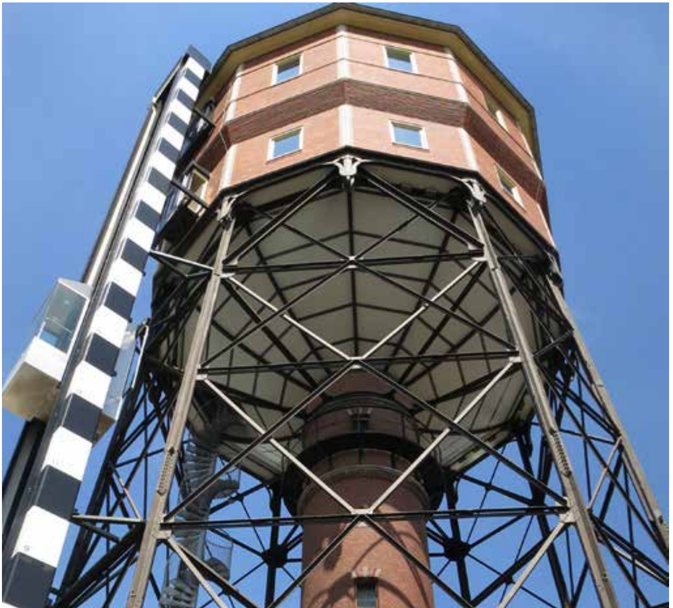
Watertoren-Noord, functieloos geworden watertoren herbestemd tot multifunctioneel centrum, winnaar van de nationale watertorenprijs 2016.
