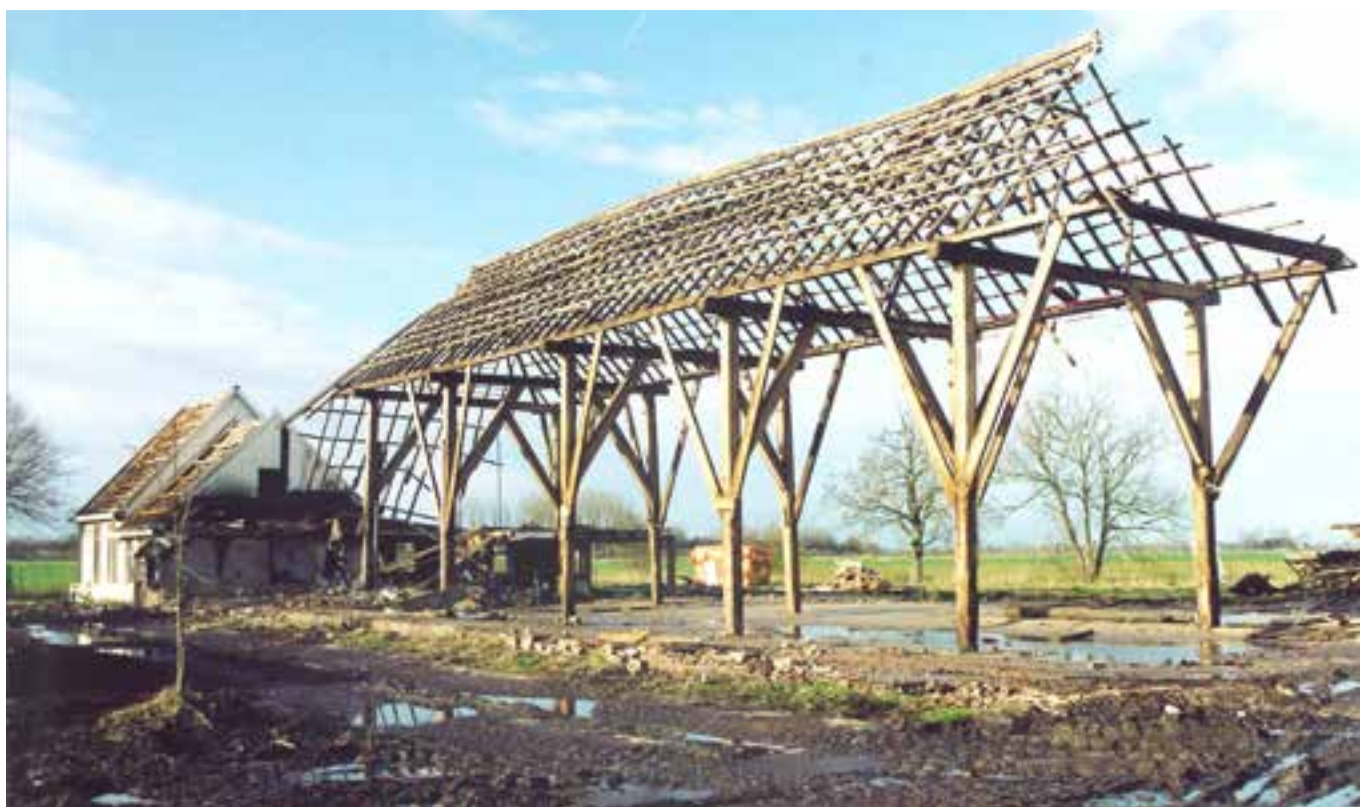
Bouwhistorisch boerderijonderzoek, Zijlvesteweg 6 tijdens de sloop, gebintconstructie uit 1794. Onderdelen zijn opgenomen in de nieuwbouw.
