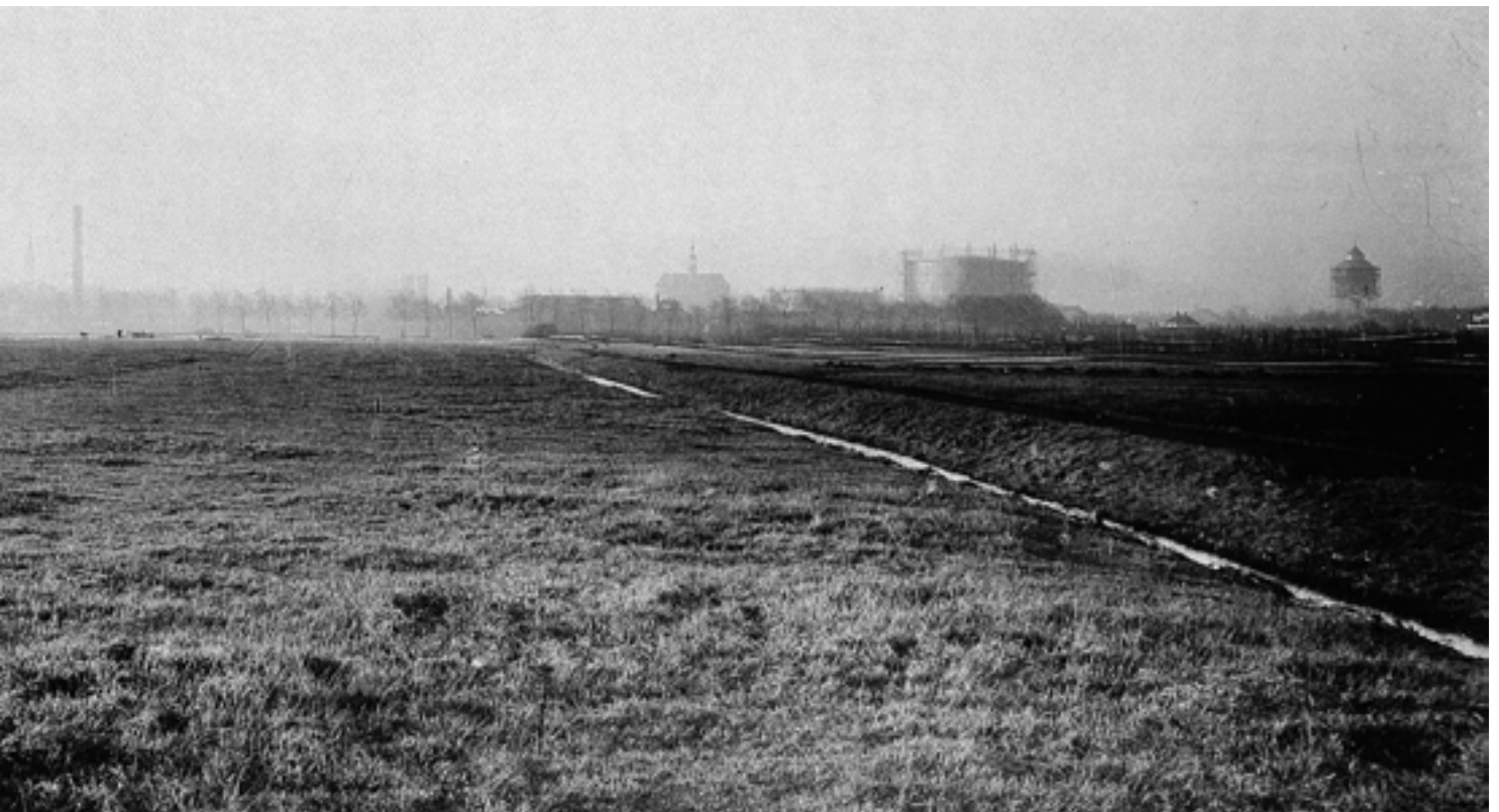
Groningen, silhouet vanuit het oosten rond 1910, met van links naar rechts de Martinitorren, de Nieuwe Kerk, een gashouder van de gasfabriek en helemaal rechts Watertoren-Noord.
