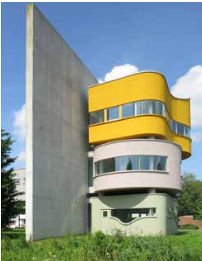
Historische rijkdom beschermen, monumenten uit de periode 1970 – 2000. Wall House #2 aan het Hoornsemeer, architect John Hejduk.
