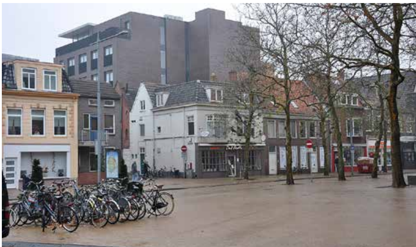
Stedenbouwkundig laadvermogen, appartementencomplex in beschermd stadsgezicht binnenstad, achter de westelijke bebouwing van de Rademarkt.
