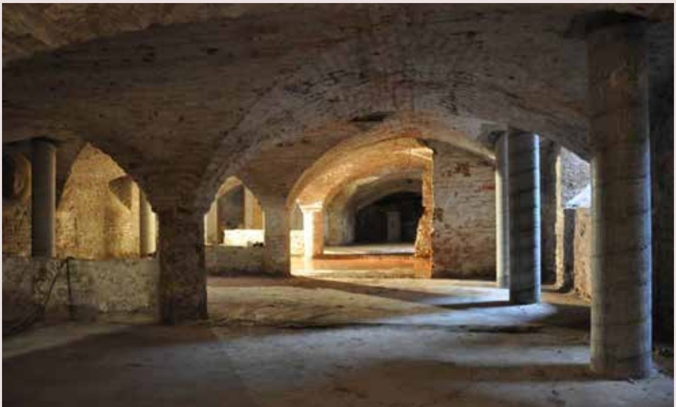
Kelder onder het Prinsenhof.
