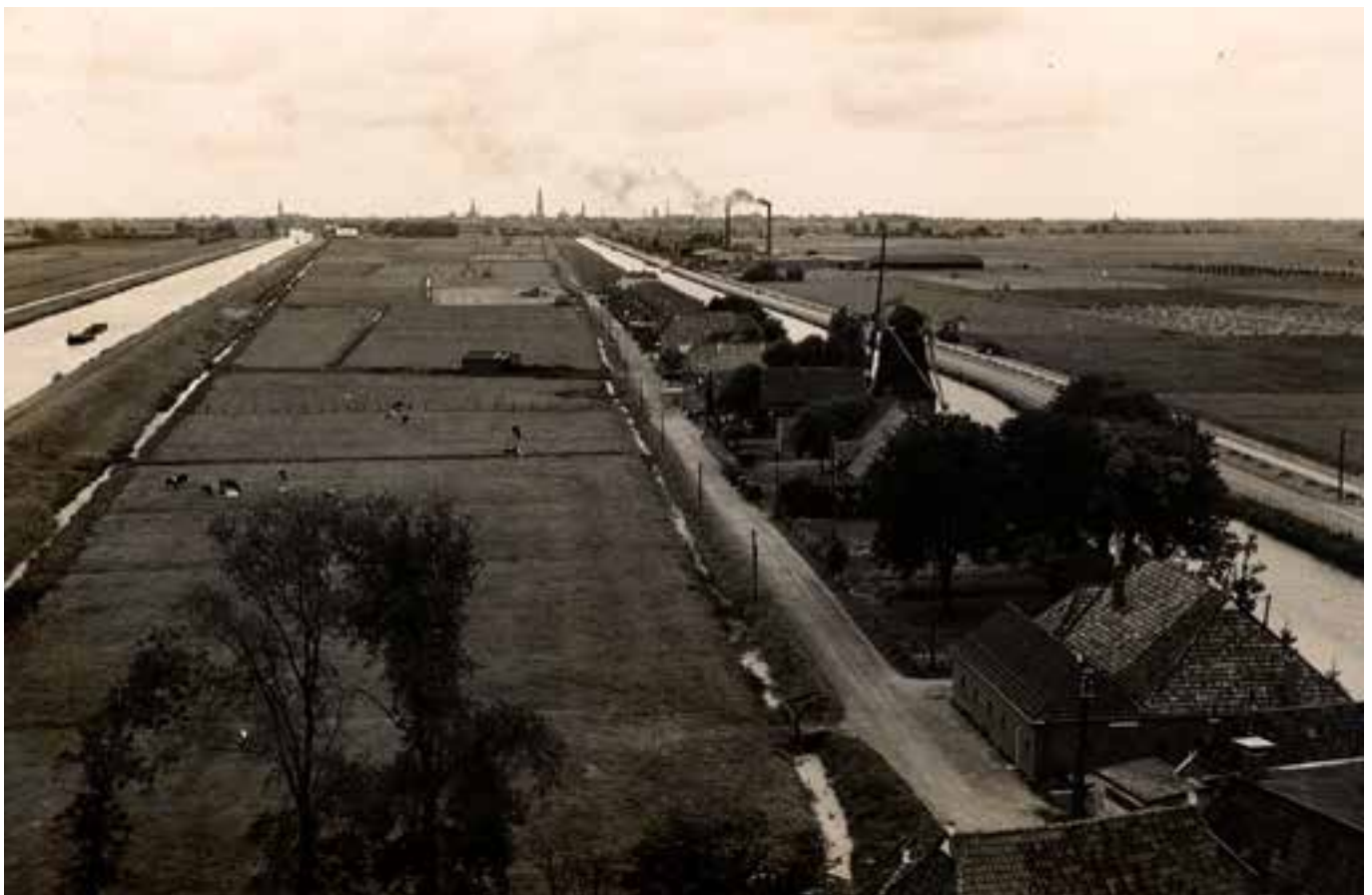
Stad in het landschap, situatie rond 1900 gezien vanuit het oosten. Alle wegen leiden naar de stad, links het Eemskanaal (1876) en rechts het in de 15 e eeuw in de zichtas van de Martinitoren gegraven Damsterdiep.
