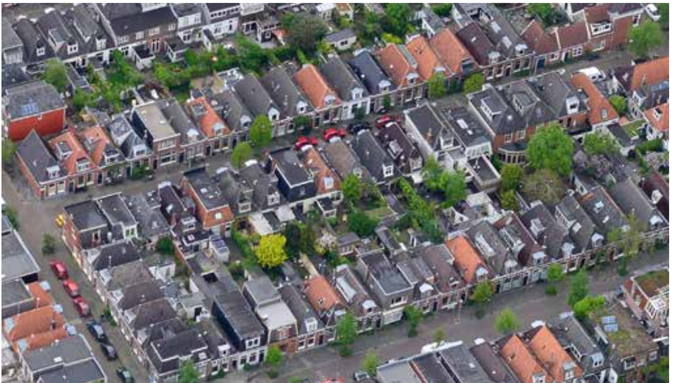
Planologische bescherming, voorbeeld 3: Noorderplantsoenbuurt, karakteristieke eenlaagse bebouwing met kap, onbeschermd erfgoed, niet monumentaal genoeg om als monument te beschermen, kan nu zonder enige erfgoedafweging worden gesloopt.
