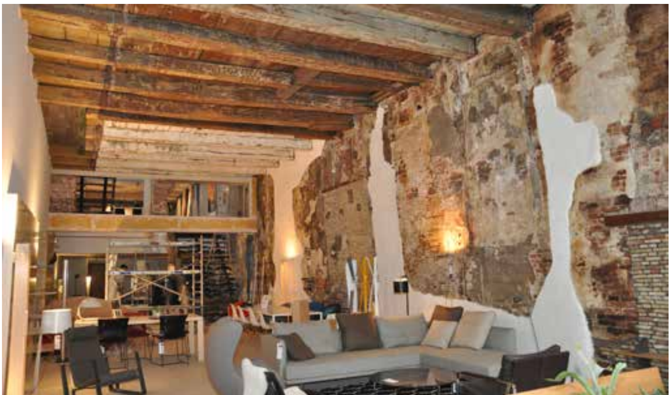
Erfgoed ontdekken, Oosterstraat 42, vrijgelegd middeleeuws casco in gebruik als interieur voor moderne winkel voor wooninrichting.
