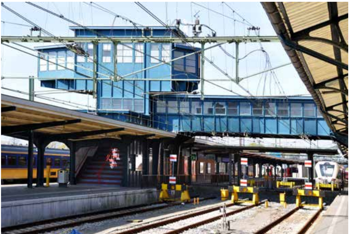
Herontwikkeling, Hoofdstation, traverse en seinpost T uit 1928, beschermd als gemeentelijk monument, herbestemmingsopgave in de transformatie van het stationsgebied.
