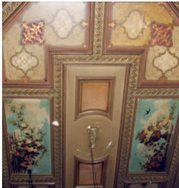
Hereweg Koepel, Stucplafond
