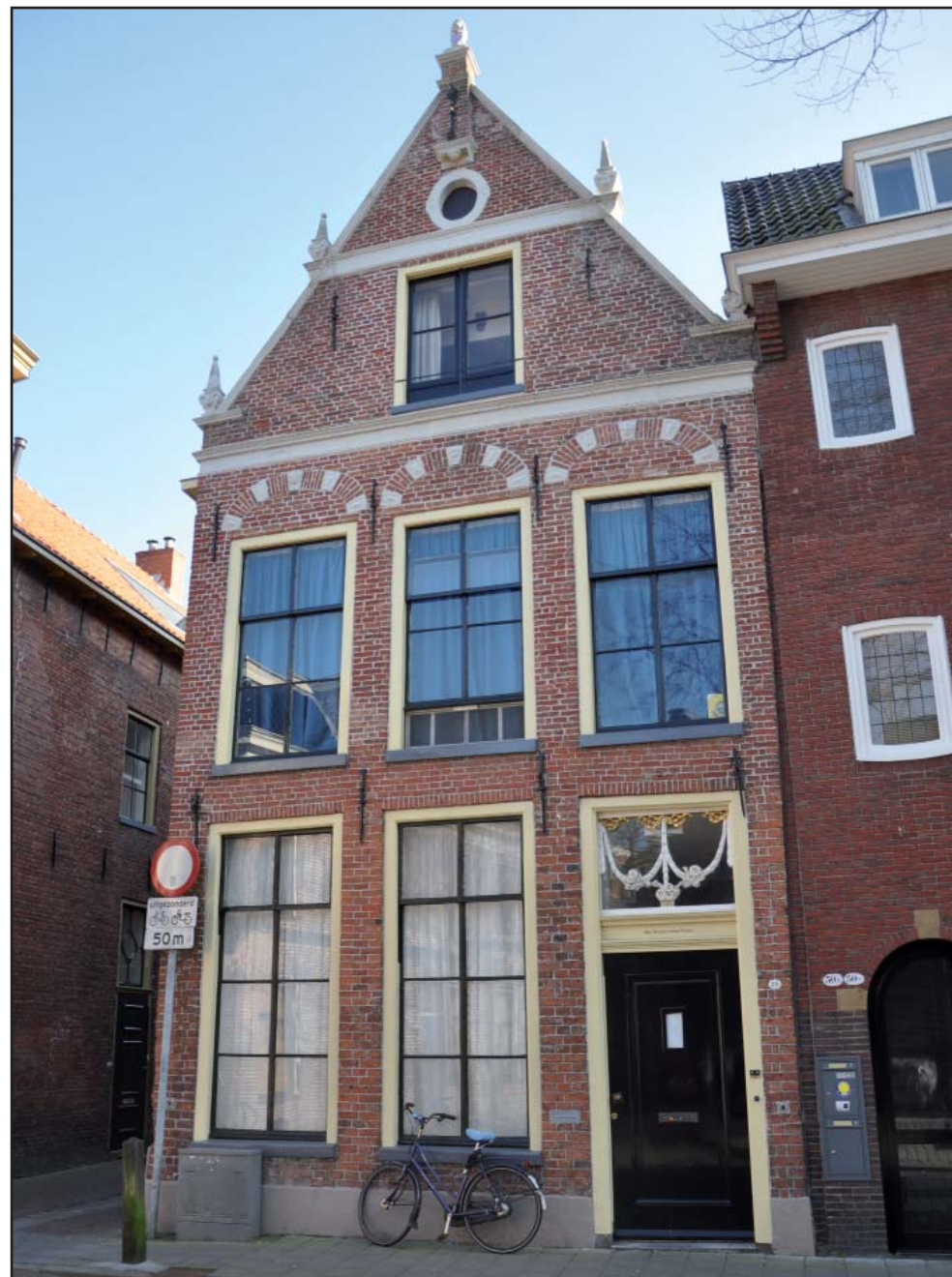
Turftorenstraat 28 met 17 e -eeuwse schoudergevel
