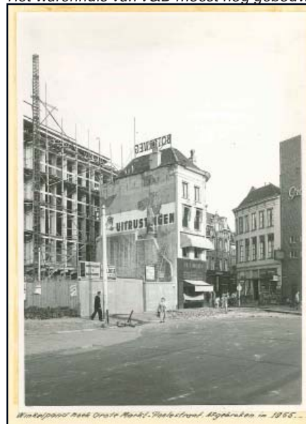
De entree van de Poelstraat en de Oosterstraat in 1955 met nog de oude hoekbebouwing terwijl daarachter de nieuwbouw, die de nieuwe straathoek zal vormen, in de steigers staat.
